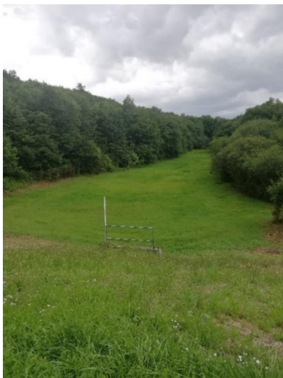
Figure 52 : Photo 1 de l'ouvrage écrêteur Terrier Mouton (Source : Mayane)
