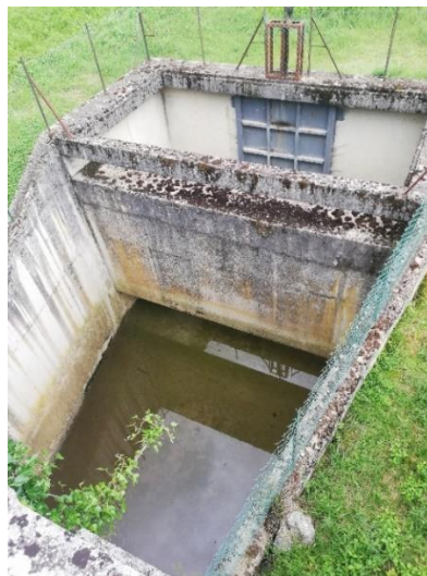
Figure 53 : Photo 2 de l'ouvrage écrêteur Terrier Mouton (Source : Mayane)
