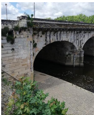
Figure 82 : Echelle de la station Vigicrues de Châtellerault sur la Vienne (Source : Mayane)
