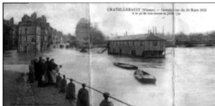
Figure 33 : La Vienne en crue sur la commune de Châtellerault (Source : EPTB Vienne)
