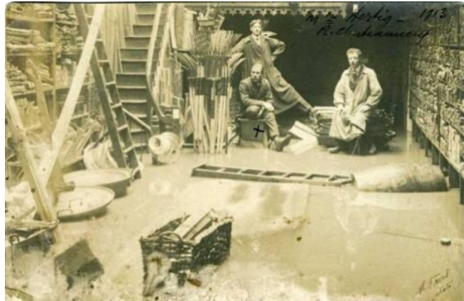
Figure 31 : Sous-sol inondé du magasin Hertig, Grande-rue de Châteauneuf en 1913, coll particulière (Source : EPTB Vienne)
