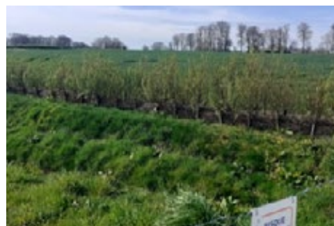
Fascine vivante (assemblage de branchages) Source SMBVCS
