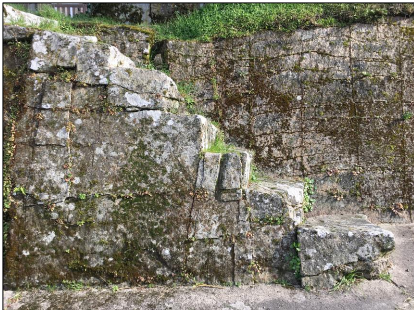
Figure 11 : Horizon fissuré du granite, débité ici pour tailler des escaliers, La Chapelle Baloue (Creuse)
