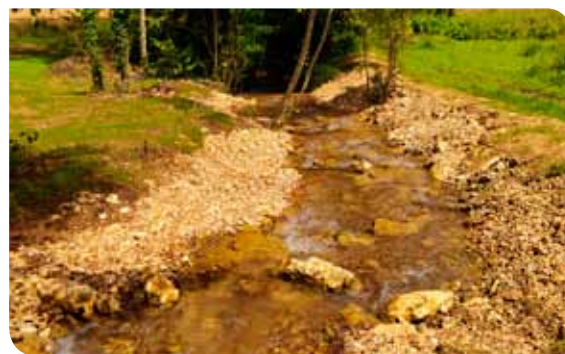
Restauration de cours d'eau sur le bassin du Clain
