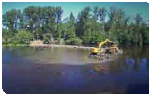
Photo des travaux d'arasement Source : Basalte Images
