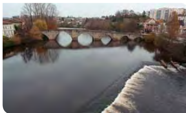
Seuil sur la Vienne à Limoges
