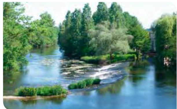
Seuil sur la Gartempe
