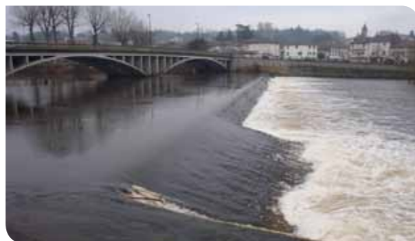
Seuil sur la Vienne
