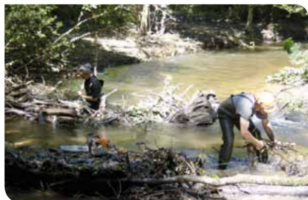
Travaux sur cours d'eau ©PNR ML
