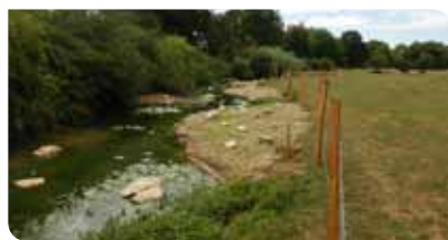
Restauration de la Chaussée (source SMVCS)
