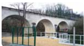
Captage de la Varenne
