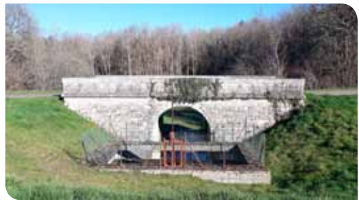
Ouvrage de Terrier-Mouton sur le Talbat
