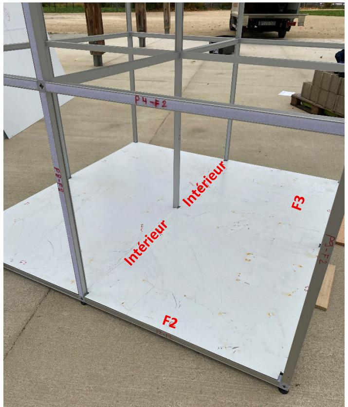
N°12 : Chaque panneau est muni des perforations nécessaires à sa fixation sur la structure, à l'aide de la visserie fournie. Pour chacune des faces, visser **dans les perforations préexistantes** les panneaux en respectant scrupuleusement l'association des profilés avec le code du panneau. **Il est strictement interdit d'effectuer tout percement ou modification supplémentaire pouvant altérer l'intégrité du matériel.**
