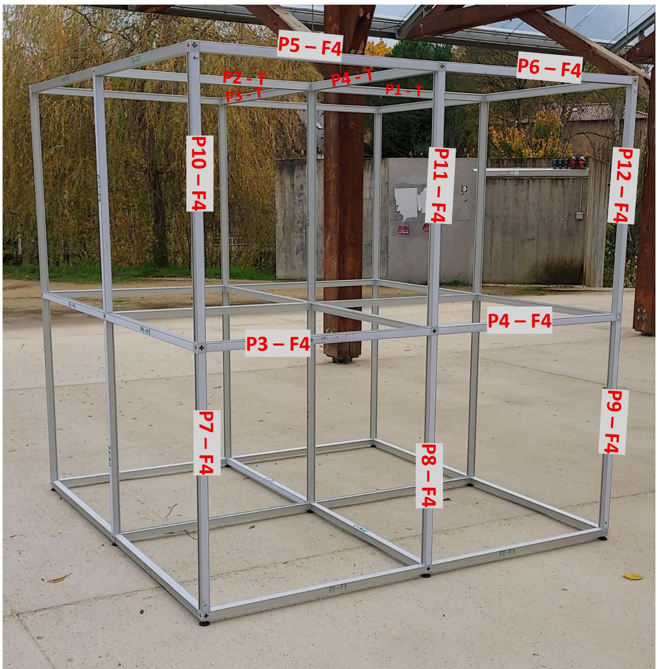
La structure étant maintenant entièrement formée, il est possible d'y ajouter le plancher, le lestage et d'y visser les panneaux imprimés ainsi que le toit.
