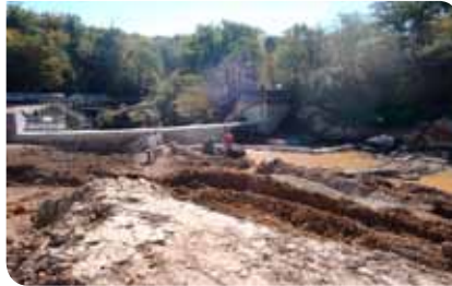
Travaux de démolition du barrage 29/09/17
