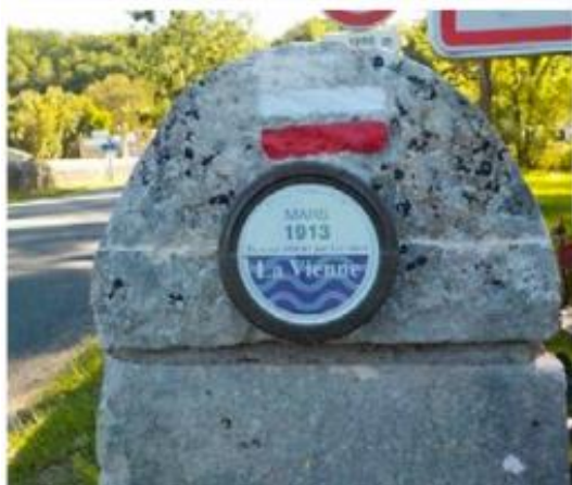
Figure 78 : Repère de crue matérialisé par un macaron normalisé sur la commune de Bellefonds (Source : EPTB Vienne)
