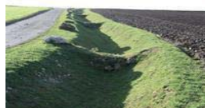
Fossé à redents
